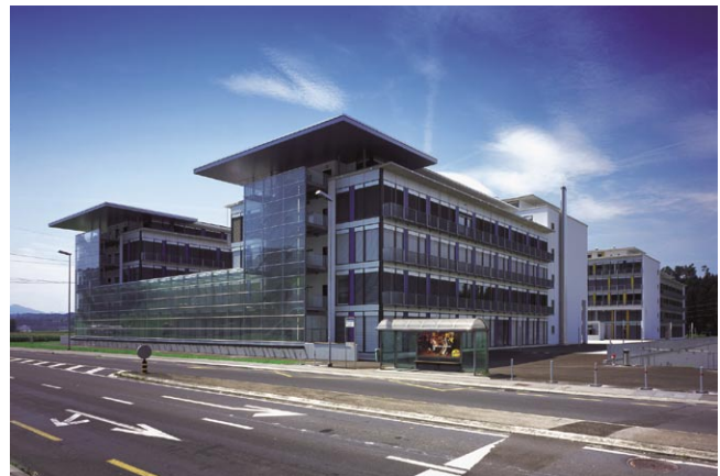
Bâtiments de la première étape du Centre D4 de la SUVA.
