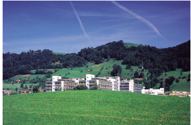
Vue d'ensemble du Centre D4 à Root, Lucerne.
