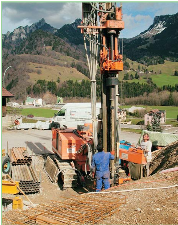
▲ Installation einer Erdwärmesonde in einem Einfamilienhausquartier in Enney, Fribourg
